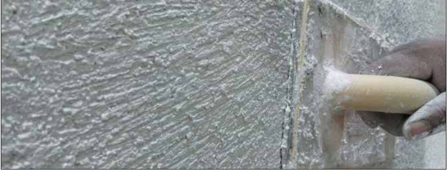
Şekil 94: Perlitin sıva içinde kullanılması
