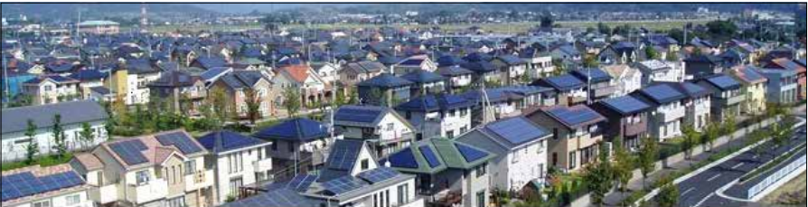
Şekil 13. Japonya'da çatıları güneş panelleri ile kaplanmış şehirden bir görüntü.
