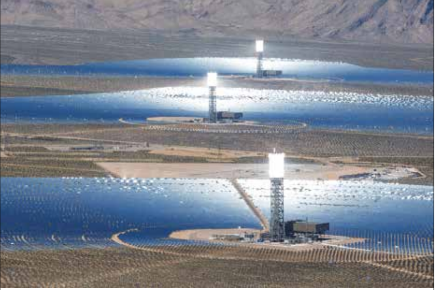
Şekil 14. Aynalı türbin sistemi kullanarak Güneş enerjisinden elektrik üreten ABD Ivanpah CSP Güneş Santrali.
