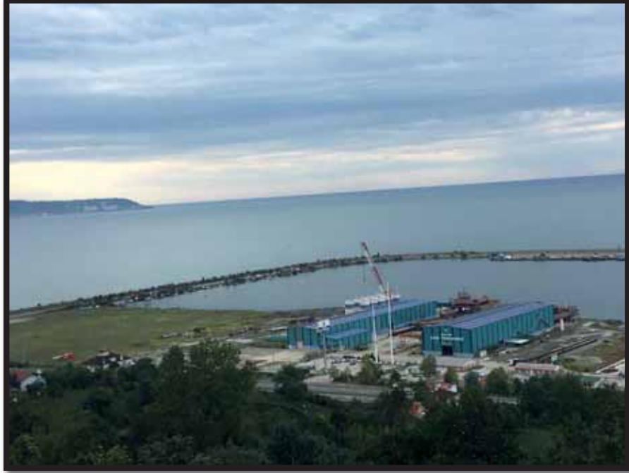
Şekil 142: Trabzon'daki küçük tersane alanını gösteren resim
